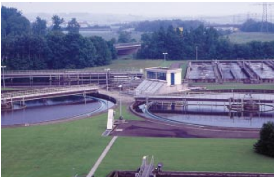
Die biologische Anlage auf einen Blick: Belebungsbecken, Rücklaufschlamm-pumpwerk und Nachklärbecken
