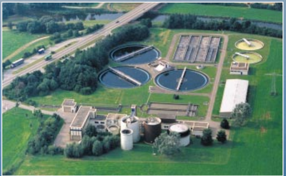
Die Verbandskläranlage in Donaueschingen
