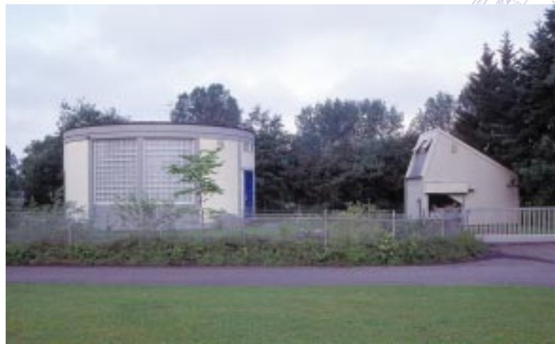
1.700 Kubikmeter fasst das Regenüberlaufbecken im Haberfeld
